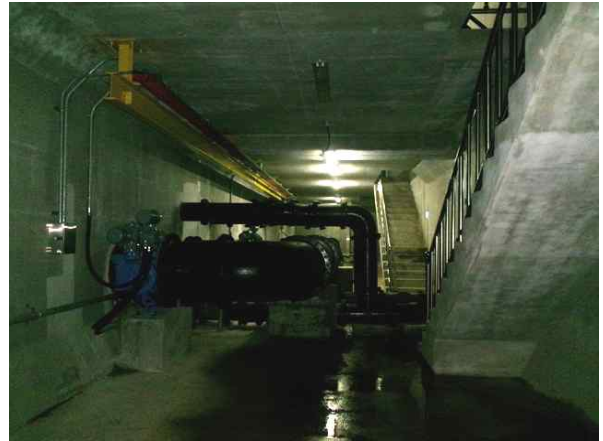
유출밸브실(지하2층) 내부 전경
