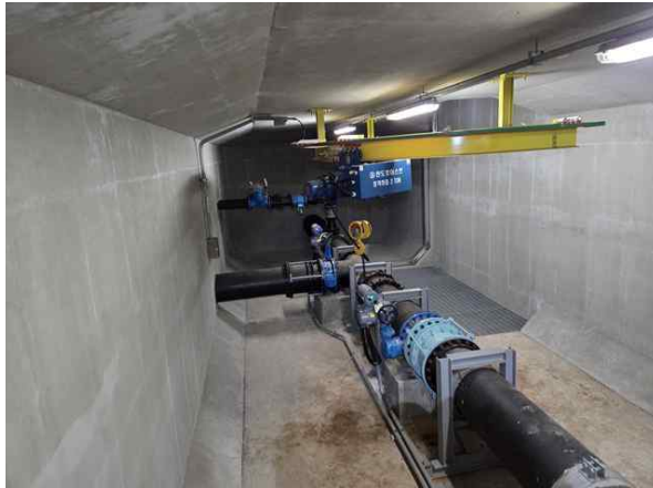
유입밸브실(지하1층) 내부 전경
