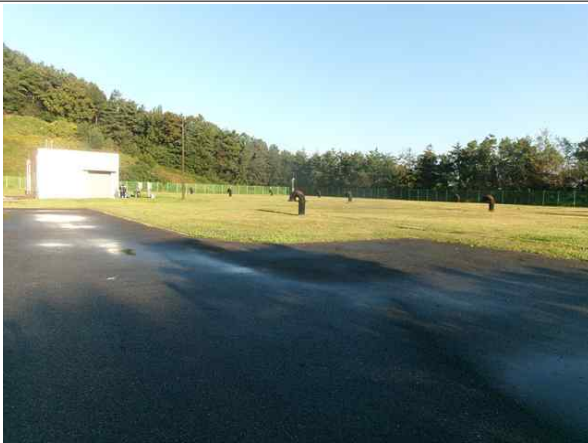
배수지 상부 현황
