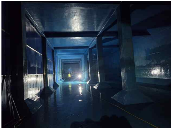
배수지 1지 내부 전경
